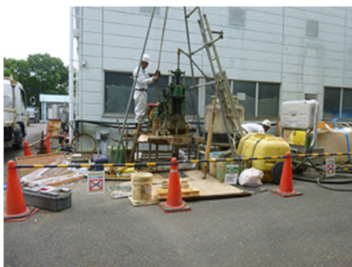
土壤浄化工事
