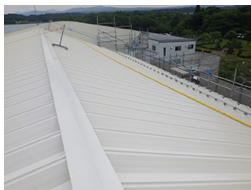
福島工場食堂屋根の遮熱塗装
