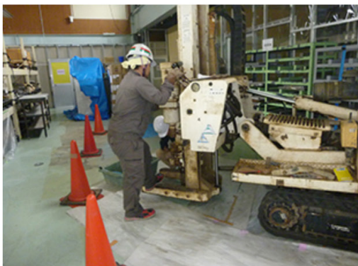
土壤浄化高濃度箇所の薬剤投入井戸設置
