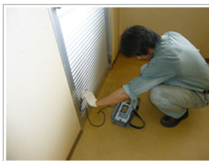
喫煙室内に吸い込まれる空気の風速測定
