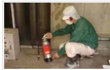
消火器の点検作業
